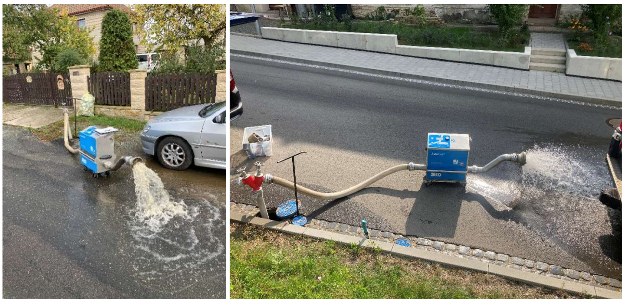
Obr. 1 Čištění vodovodního potrubí – proplach přes hydrant
