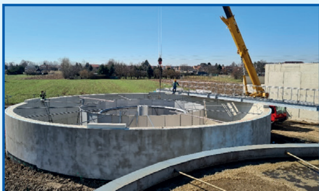
Práce na vystrojení nádrže nové biologické jednotky
