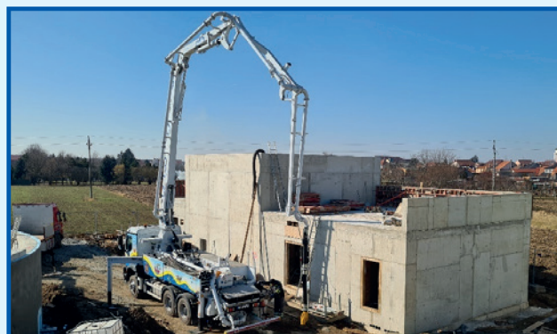
Betonáž sdruženého objektu, jehož součástí je nový kalojem, dmýchárna, rozvodna a sklad
