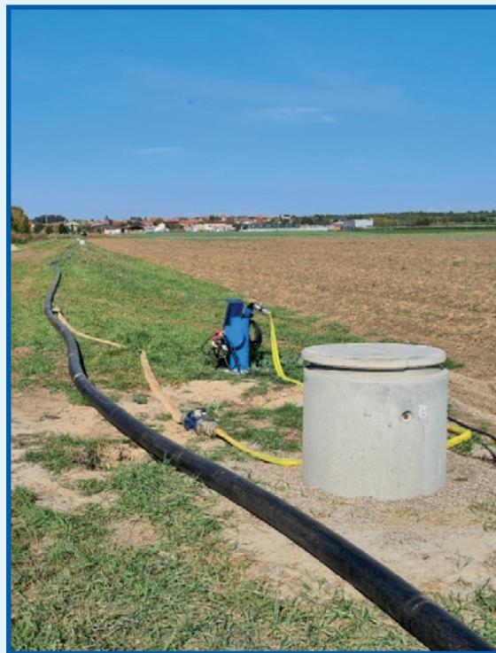
Probíhající čerpací zkoušky
