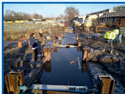
Fotografie zachycují realizaci díla při provizorním přehrazení Mlýnského náhonu
