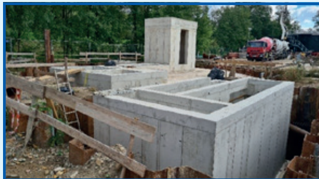
Dokončené betonářské práce
