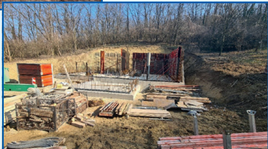
Betonářské práce na stavbě nového vodojemu
