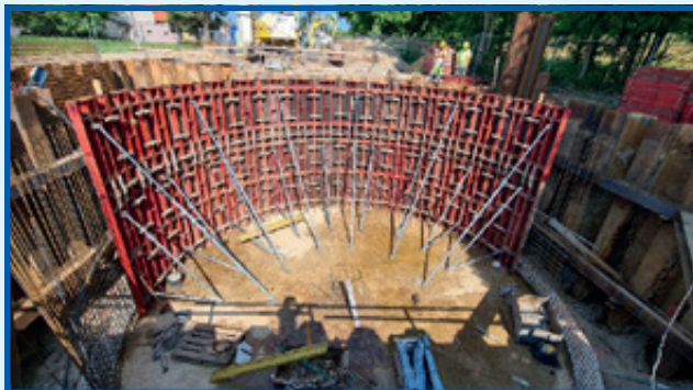
Práce na výstavbě kruhové retenční nádrže
