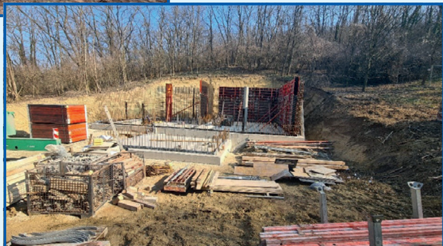
Betonářské práce na stavbě nového vodojemu
