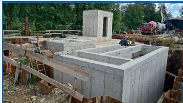
Dokončené betonářské práce
