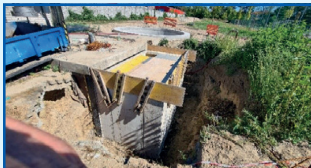
Pohled na novou akumulární nádrž na čerpací stanici U hřiště Probíhající stavební práce v areálu čerpací stanice
