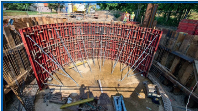
Práce na výstavbě kruhové retenční nádrže
