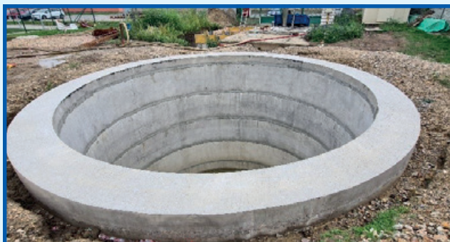
Pohled na novou akumulární nádrž na čerpací stanici U hřiště Probíhající stavební práce v areálu čerpací stanice
